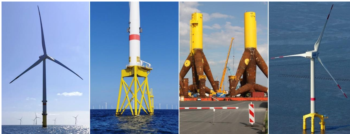
Abbildung 13: Fundamente von OWEA. Von links: Monopile, Jacket, 4-beiniger Tripod, Tripile (Foto ganz rechts: Martina Nolte, CC BY-SA 3.0 de, alle übrigen: itap GmbH).
