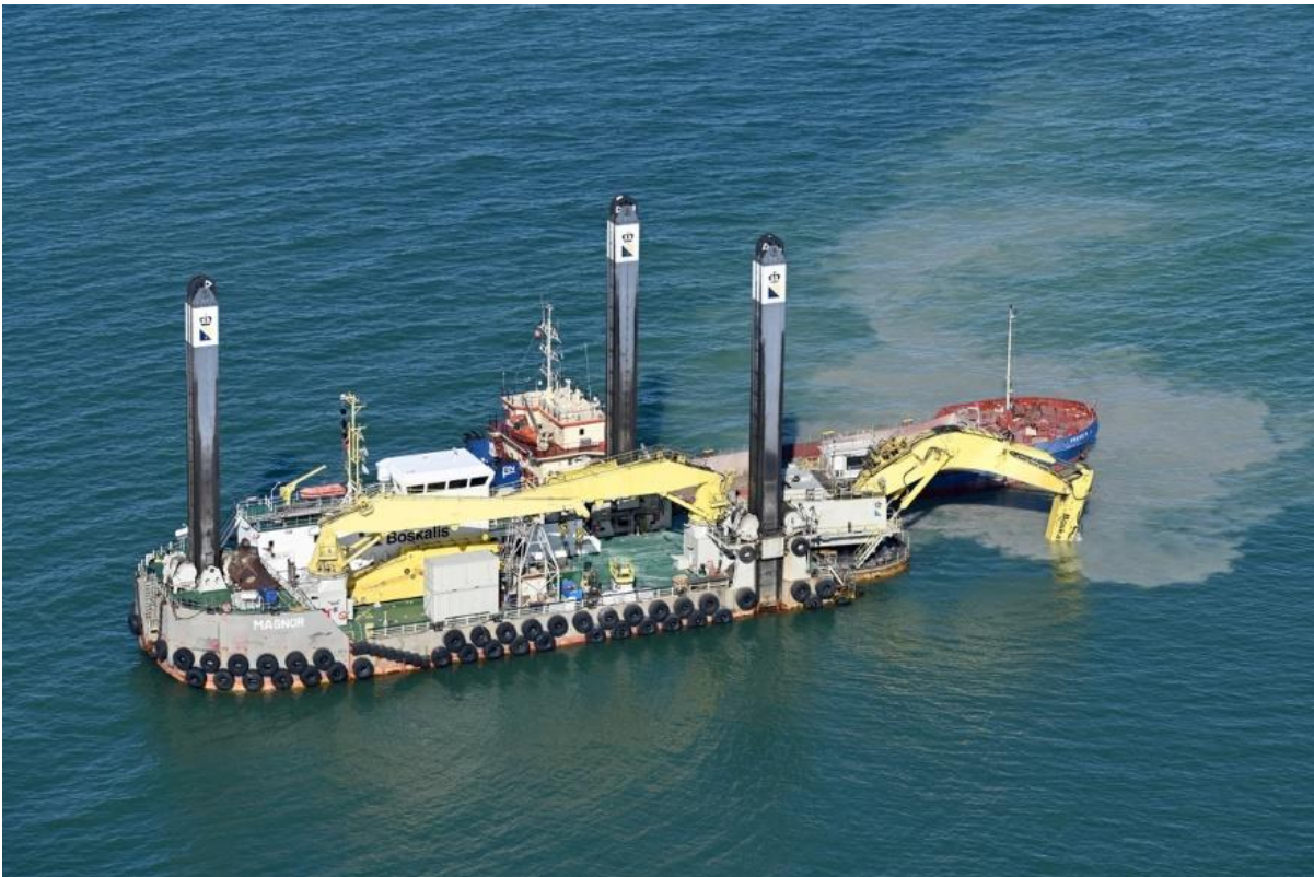
Abbildung 30: Schwimmbagger Magnor bei Aushubarbeiten der Fehmarnbeltquerung (© Femern A/S)
