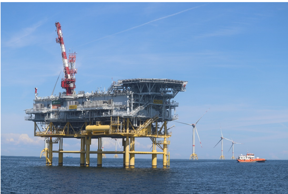
Abbildung 5: Windenergieplattform im Windpark Wikinger (© BSH/Dominic Plug)
