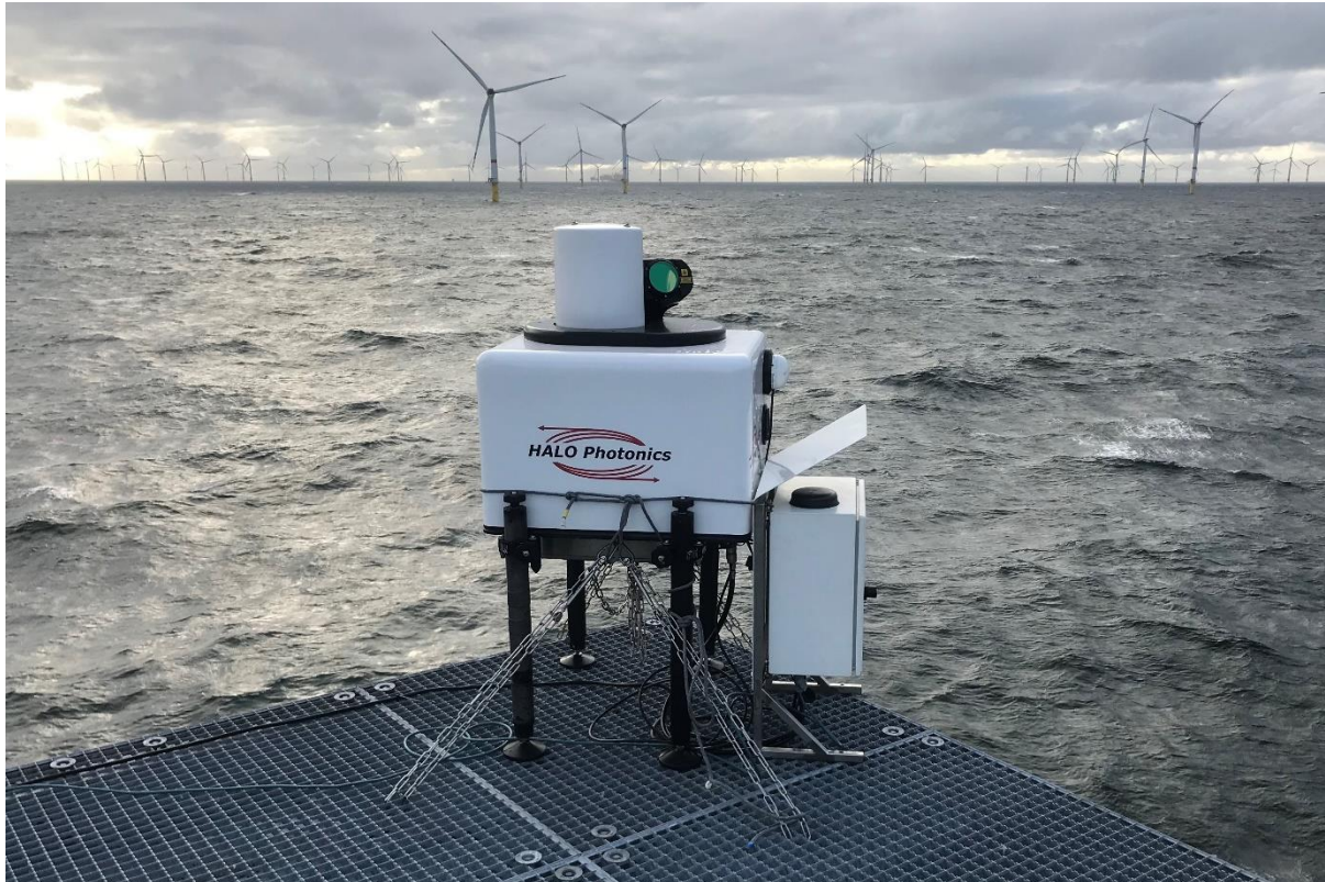
Abbildung 7-3: Scanning Lidar, auf der Westecke des Containerdachs installiert.
