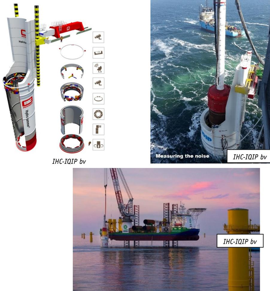
**Abbildung 27:** Noise Mitigation Screen der Fa. IHC IQIP bv. Links oben: technische Konstruktionszeichnung des doppelwandigen Stahlrohres inkl. innenliegender Pfahlführung; rechts oben: IHC-NMS im Offshore-Einsatz (Nahaufnahme); unten: IHC-NMS im Offshore-Einsatz. (Quelle: IHC IQIP bv)
