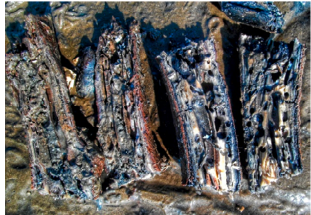
Abbildung 2-1 | Vom Schiffsbohrwurm befallene Holzbalkenfragmente am Strand von Cuxhaven. Foto: Zabrocki / BSH.
