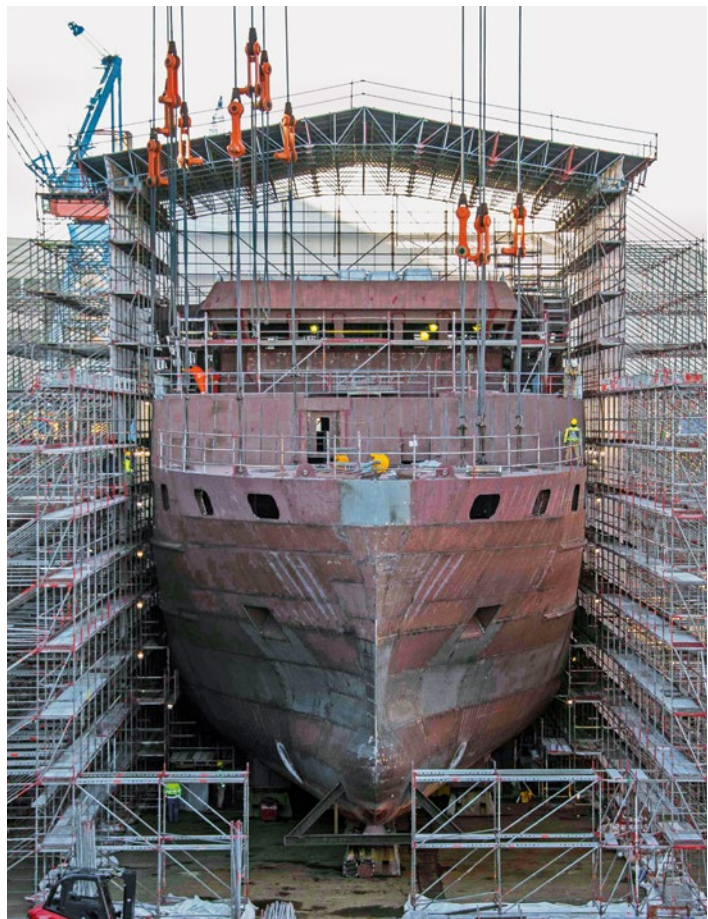
Ein Schiff entsteht – die zukünftige ATAIR ingerüstet im Trockendock
